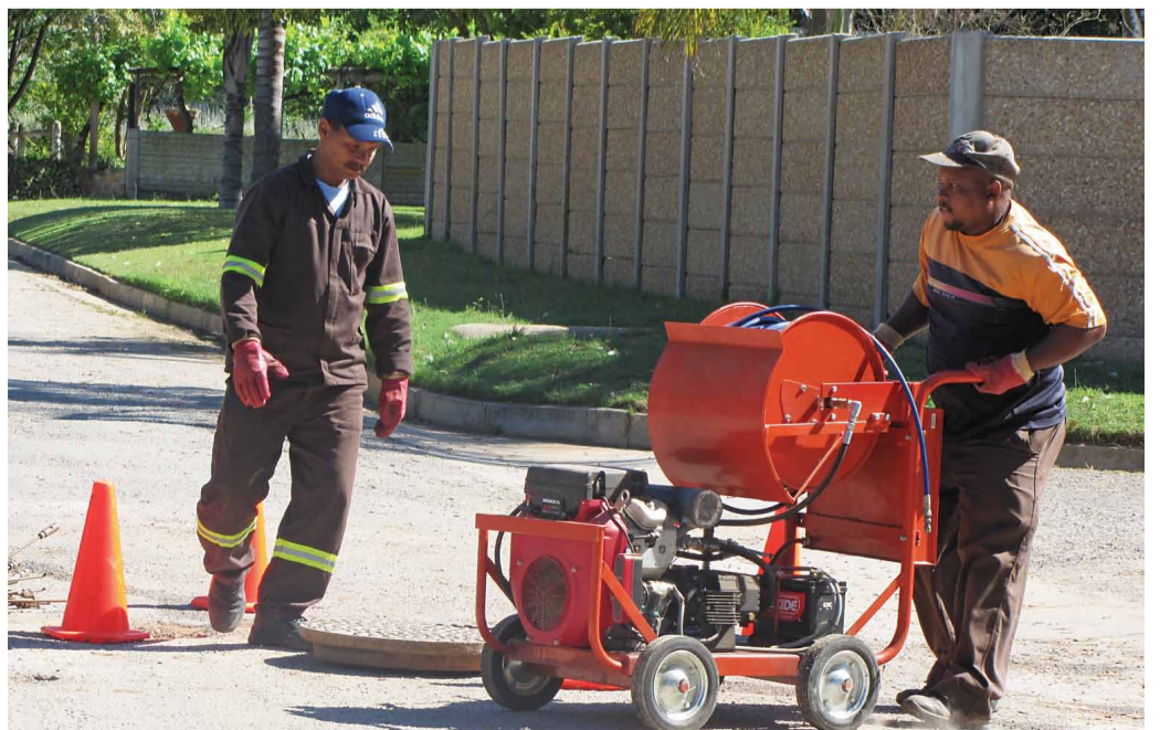
Munisipalewerkers besig met instandhouding
